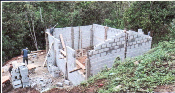
Foto1: MEJORAMIENTO DE AULA TIPO PÓRTICO
