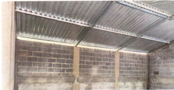
Foto 3: MEJORAMIENTO DE TECHO
