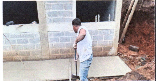
FOTO2. MEJORAMIENTO DE PISO
