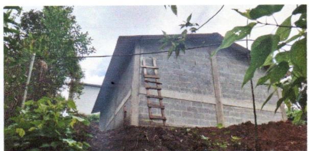
Foto 6: MEJORAMIENTO E INSTALACION DE LÁMINA TROQUELADA CALIBRE 26
