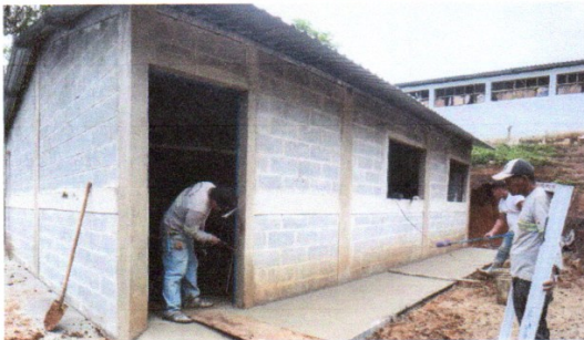
Foto 5: MEJORAMIENTO DE PUERTA
