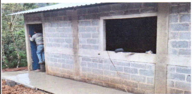
Foto 4: MEJORAMIENTO E INSTALACION DE VENTANA Y BALCON
